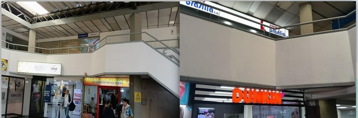
Pintura Antepechos Pasillo Principal M1, M2, M3 (811,35 m2).
