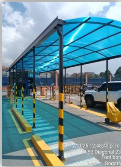
Cubierta punto de pago parqueadero
