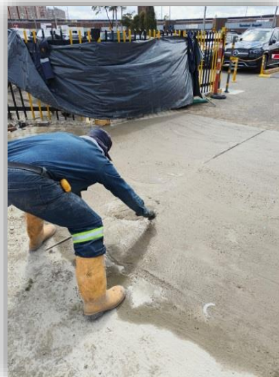
Arreglo Placa Concreto Ingreso Peatonal y Salida Vehicular (55,68 m 2 ).
