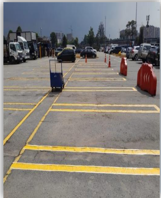
Demarcación Celdas Parqueadero carros Pequeños Costado Norte.
