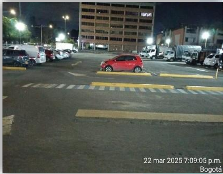
Iluminación: Instalación de 9 Postes y 16 Reflectores
