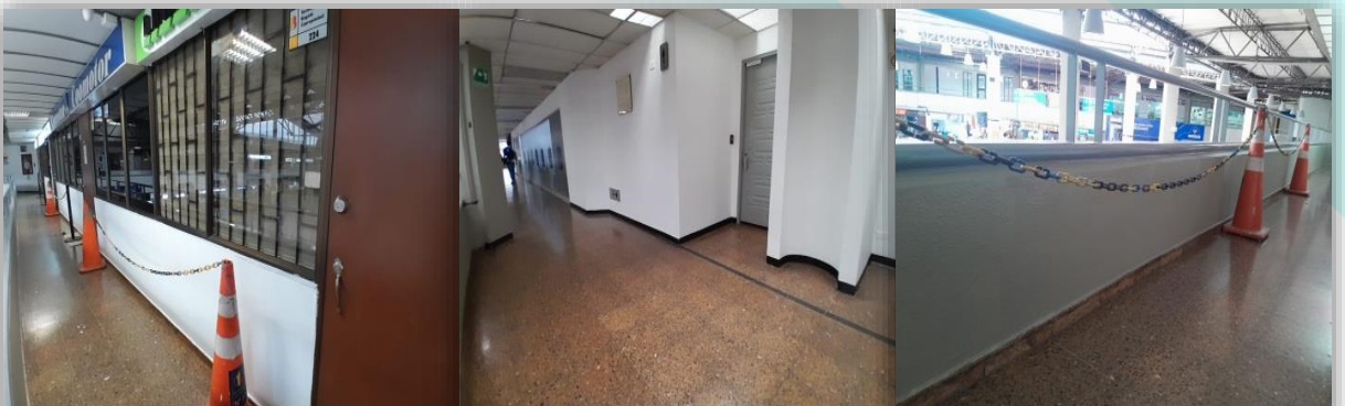
Pintura Paredes, Columnas Y Barandas Segundo Nivel Módulos 1, 2, 3 (1444,34 M2).
