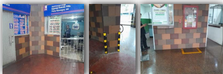
PINTURA PLATAFORMA Y ROTONDA ENCOMIENDAS (272 M 2 ) E INSTALACIÓN DE 10 ESQUINEROS EN CAUCHO
