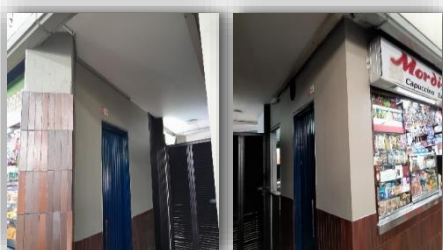
PINTURA PAREDES ZONA ENTRE TAQUILLAS M1, M2, M3
