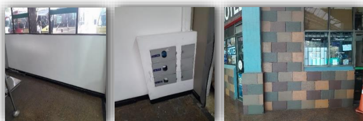
PINTURA PAREDES Y COLUMNAS SALA ESPERA M4 (83.40 M 2 ) Y FACHADA M5 PISTA 1 (60 M 2 )
